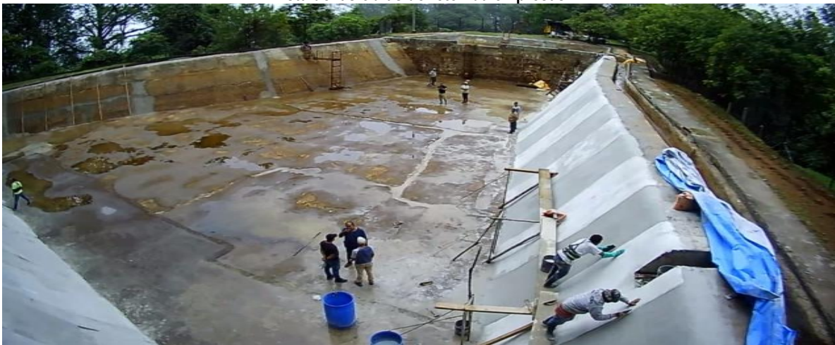
Reparación de caja central que funciona como un desarenador Imágenes 3.1 – Obras de Mejoramiento en Tomas de Agua Aguas Arriba PTAP El Picacho Fuente de las imágenes: UMAPS
