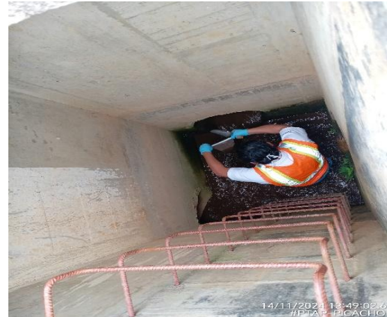
Toma de muestra fango húmedo (fresco) en Caja de Registro del Decantador
