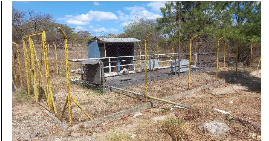
Planta de tratamiento- escuela técnica
