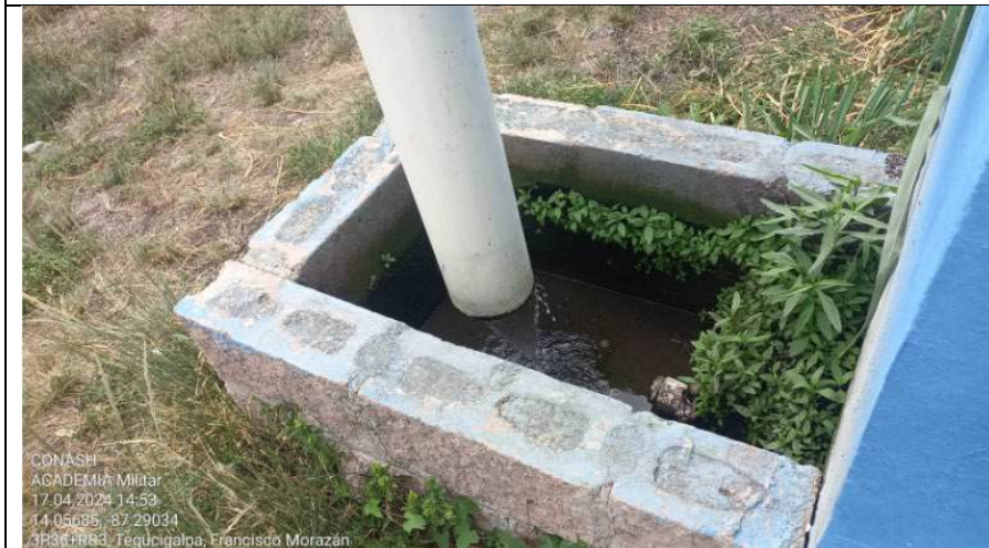
Salida de la planta
